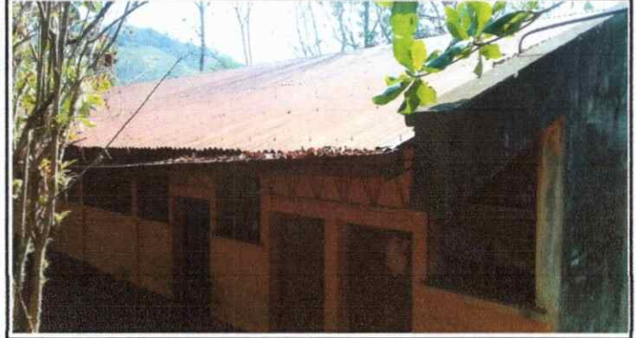
Foto 2: Sustitución del techo del módulo 2
