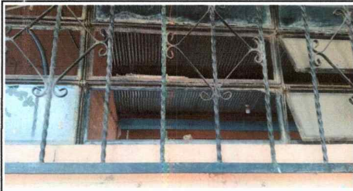
Foto 3: Sustitución de vidrios al módulo 1
