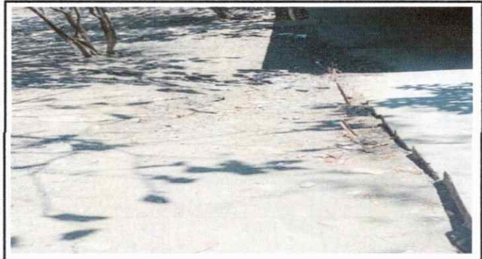
Foto 4: Reparación de rampa del módulo 1 al módulo 2
